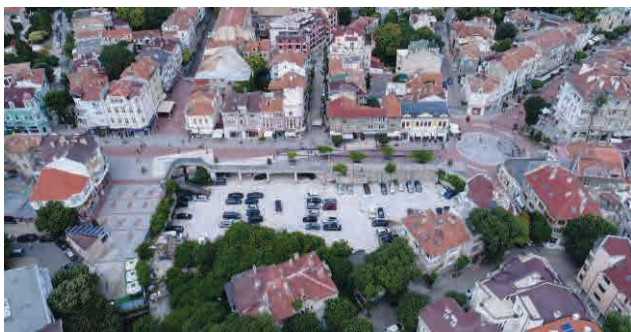
Фиг. 10. Частен платен паркинг на ниво фундаменти на спрения Търговски дом
