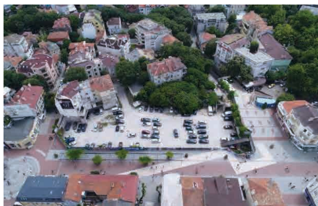
Фиг. 26. Актуалното състояние на Дупката / 2019
