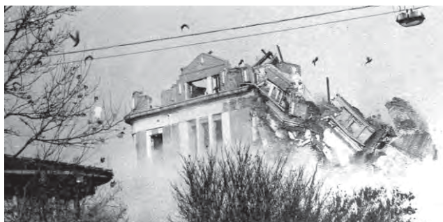
Фиг. 3. Взривяване на застрояката по ул. Княз Борис в края на 1988 г.
